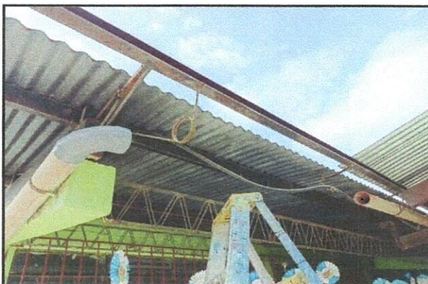
Foto 3: Cambio de tubería de bajada pluvial e instalación de canal pluvial sobre el corredor principal y corredor posterior del centro educativo.
