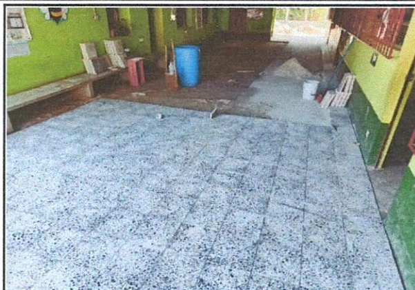
Foto 2: Instalación de piso de granito en el corredor del establecimiento.
