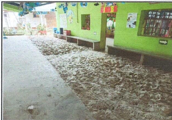
Foto 1: Preparación del suelo y compactado previo a la colocación de piso del corredor.
